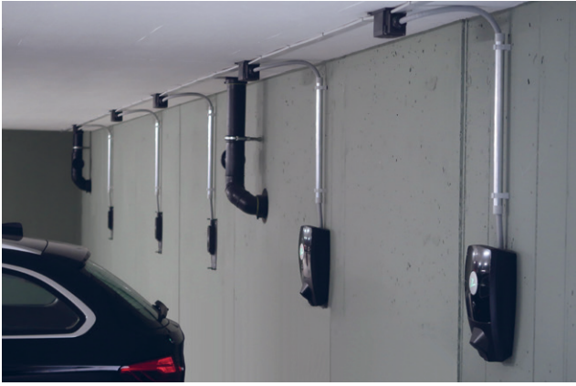
Abb. 51: Lösung mit Befestigungsplatte (Quelle: ZapChargerPro von NovaVolt).
