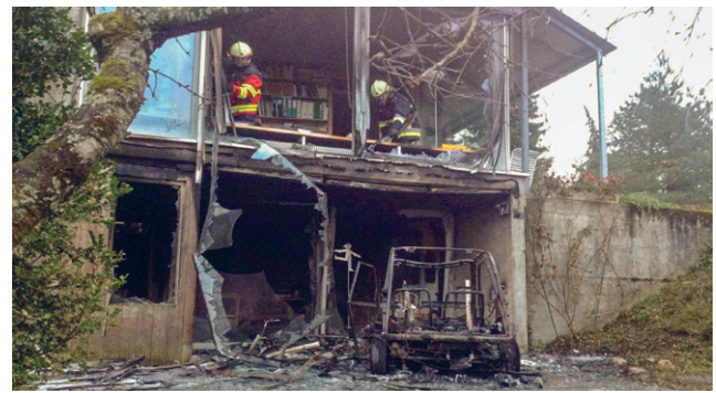
Abb. 14: Feuer bricht im Bereich der elektrischen Installation des eFahrzeuges in der Garage aus. Elektrische Widerstände führen zu einer lokalen Aufheizung der Kabelverzweigungen, einem Isolationsdefekt und verursachen schliesslich den Brand. Im Land mit der höchsten Dichte an Elektrofahrzeugen (Norwegen) wurde festgestellt, dass durch den Einsatz von Ladestationen die wenigen Fälle von Bränden während des Ladevorgangs praktisch ausgeschlossen werden konnten.
