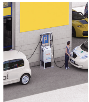
Abb. 38: Ladestation für schnelles Laden ausserhalb der Ladefläche positioniert.
