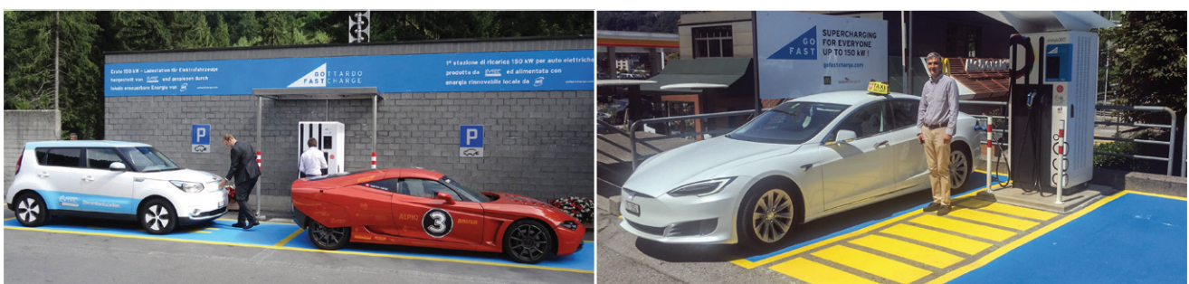
Abb. 45: Beispiel von Ladestationen mit Vordach (Quelle: Gofast).
